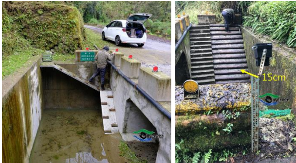
圖 9 集排水設施動物逃生坡道範例
