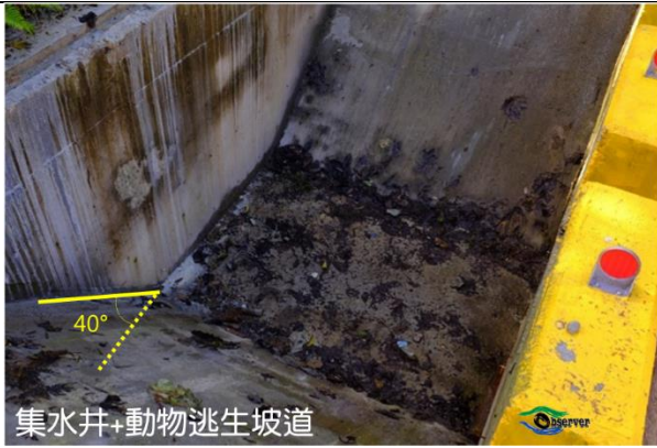
圖 8 集排水設施動物逃生坡道範例
