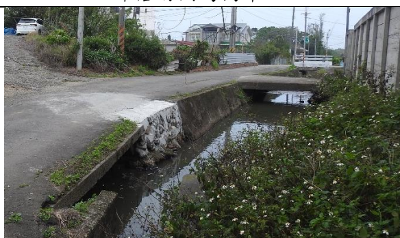
減水壩下游側溝
