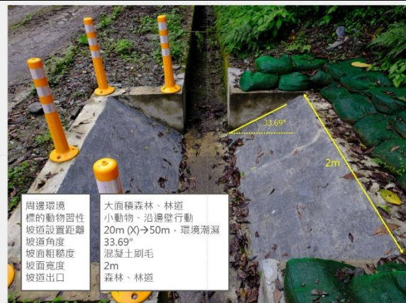
圖 5 溝渠水圳的動物逃生坡道設計範例
