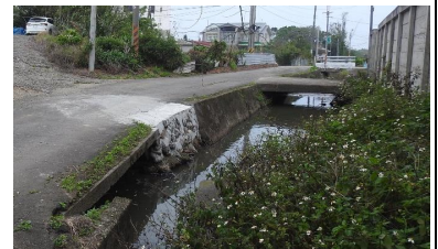
圖 13 減水壩下游側溝
