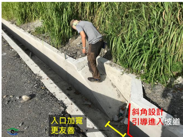
圖 6 溝渠水圳的動物逃生坡道設計範例
