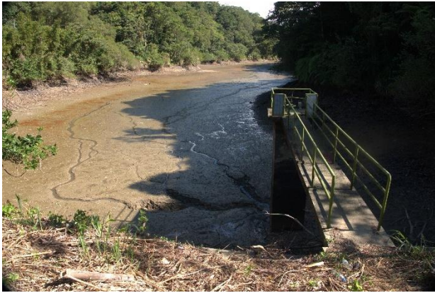
白石埤放水後樣貌
