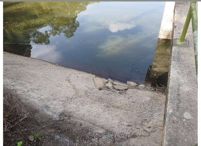
說明：給水塔工作橋側邊坡有兩處破損，工程預計使用與現況相同材質-混凝土填補，減少蓄水滲漏情形。
