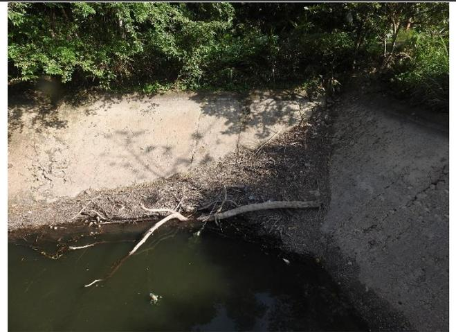
說明：工程預計於此處設置由既有道路至池底的施工便道，邊坡為混凝土組成，斜度約為 1:2。
