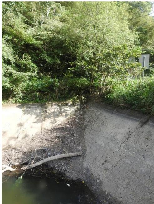
圖 2 修繕項目內面工破損數處
