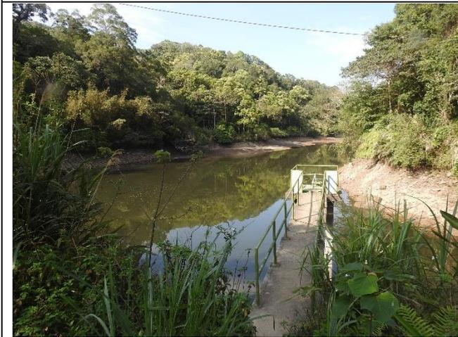
說明：給水塔工作橋現況已傾斜，工程預計於底部增加 4 支經防鏽處理的鋼構支撐，保護作業人員安全。
