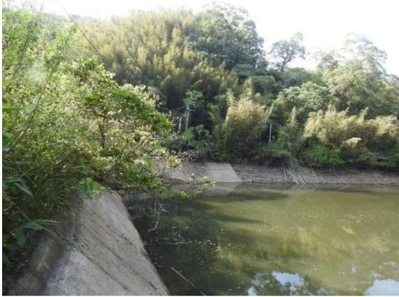
圖 3 內面工材質包括混凝土、漿砌石以及土坡
