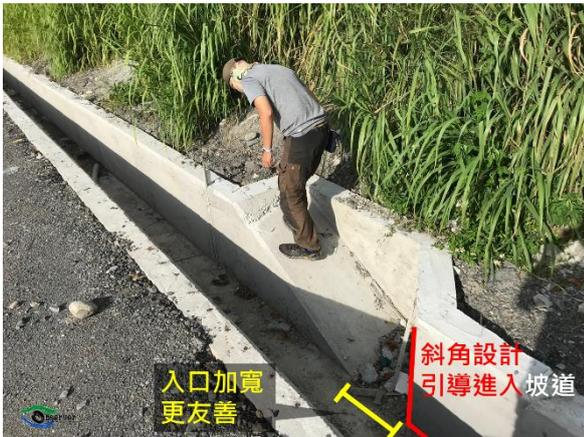
圖 6 溝渠水圳的動物逃生坡道設計範例
