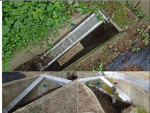
圖 7 浮動式的動物逃生坡道設計範例
