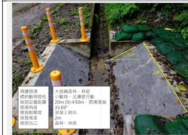
圖 2 溝渠水圳的動物逃生坡道設計範例
