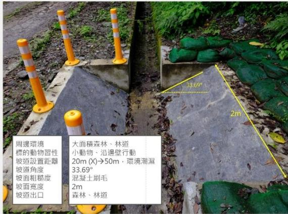
圖 5 溝渠水圳的動物逃生坡道設計範例
