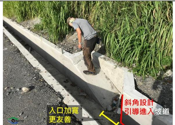
圖 3 溝渠水圳的動物逃生坡道設計範例
