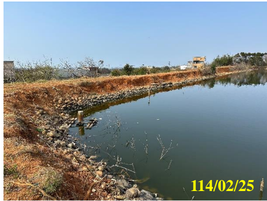
光復圳 6-2 號池頂道路
