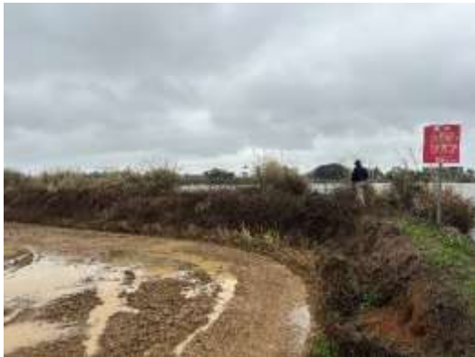
南側土坡堤頂
