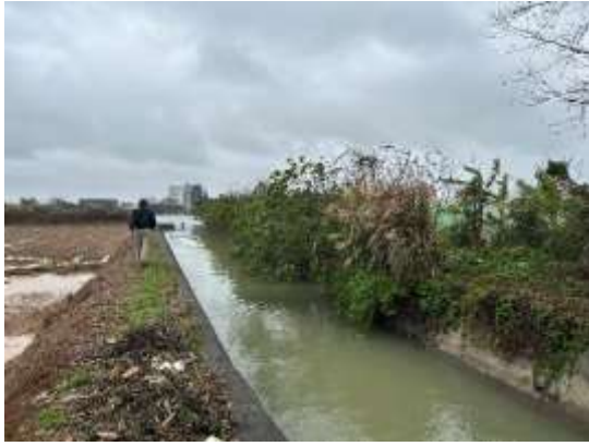
埤塘東側導水路
