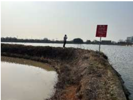
南側土坡堤頂
