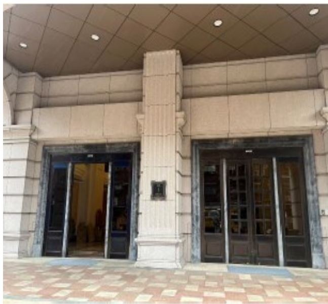
建物大廳出入口
