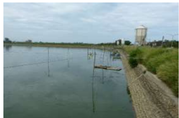
說明：堤岸水泥漿砌卵石陡坡護岸
