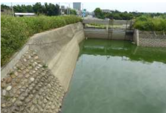
說明：堤岸水泥漿砌卵石陡坡護岸
